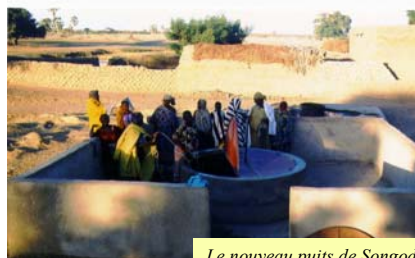
Le nouveau puits de Songodé
