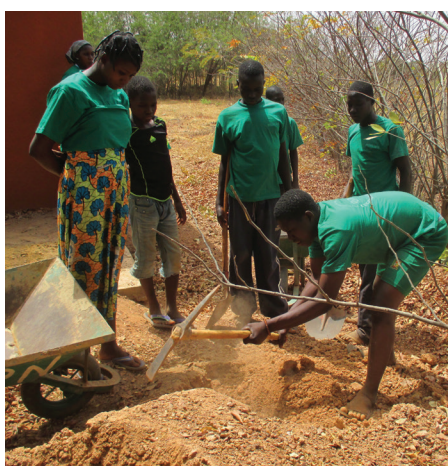
Creusement d'une fosse compostière au centre de formation
