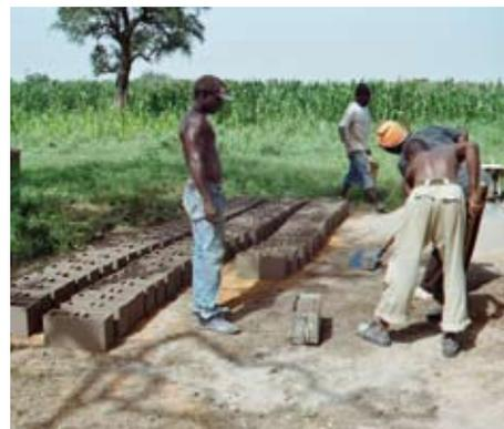
Les moellons sont fabriqués directement sur place pour les murets protégeant les pompes.
