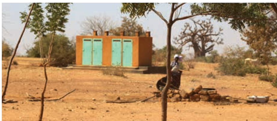
Bloc de latrines pour une école
