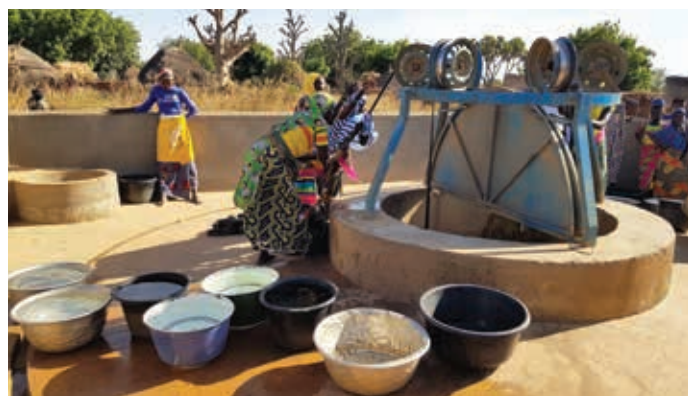
À Godé Koara puits avec aménagement de surface
